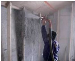
Ouate de cellulose insufflée.
